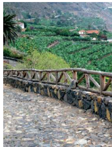
Camino Real a su paso por San Pedro
