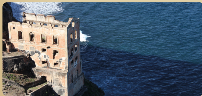
Pumpenwerk von La Gordejuela
