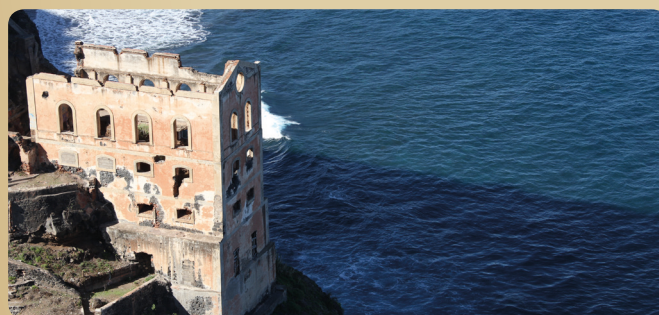
Elevador de aguas de Gordejuela
